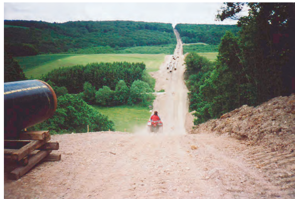
Erneuerung der Gasfernleitung
